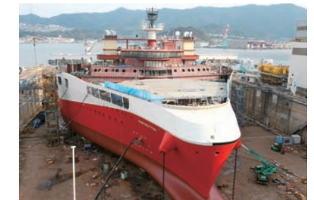
長崎造船所の香焼工場ドックで建造された
