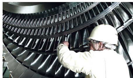
タービンの点検の様子
