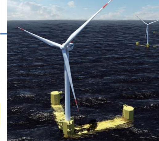
福島県沖の実証研究事業に使用される浮体式風車(イメージ)
