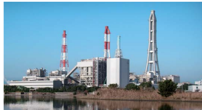
250MWのIGCC実証機。2,000時間連続運転の記録を打ち立て、商用レベルの性能であることを実証（福島県いわき市勿来発電所）
