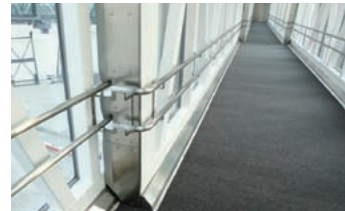
(上) 床の両脇にあった雨樋は床下に隠してすっきり、通路が広く使えるようになりました (下) 斎藤さんにとって、ユニバーサルデザイン型の旅客搭乗橋の実現は、5年越しの念願だったといいます
