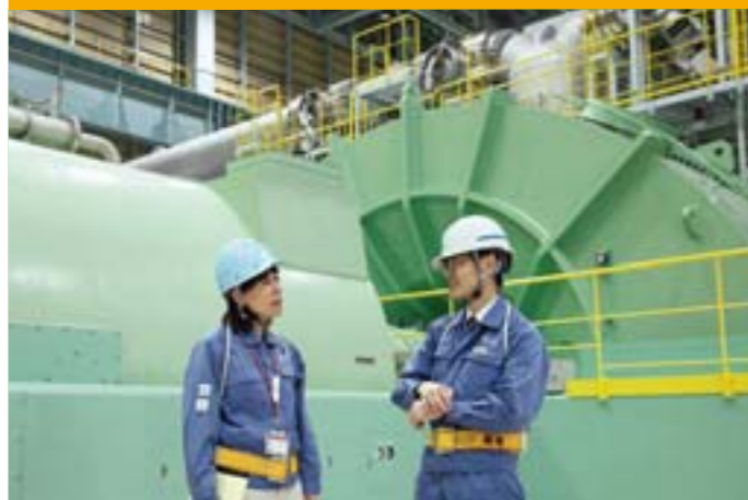
(上) 「原子炉の熱で水を蒸気に変え、その蒸気でタービンを回し発電します」と秋山さん (下) 国内最大級 54 インチ翼蒸気タービンの前で
