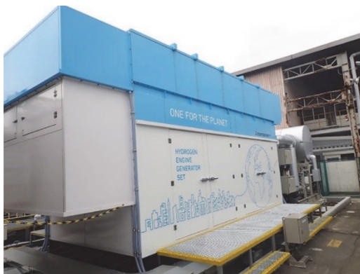
図6 水素専焼エンジン発電セット
