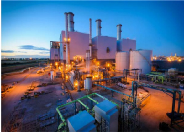
図13 イギリスのソルトエンド発電所
