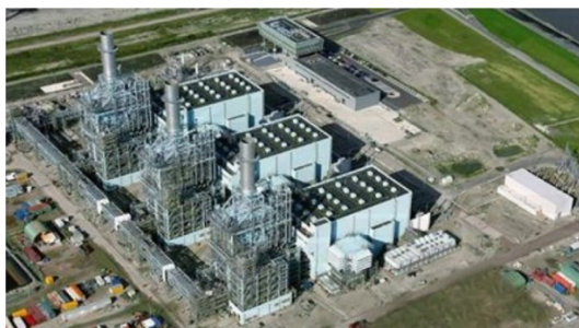
図 12 オランダのバッテンフォール・マグナム発電所
