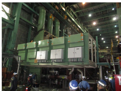
図4 新製燃料ガスユニット据付
