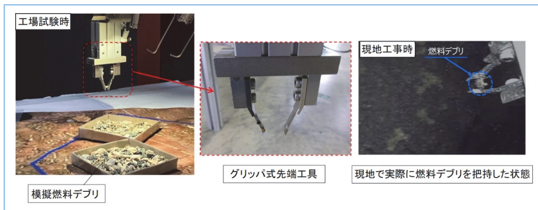
図9 先端工具要素試験と現地工事時の状況
