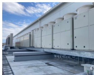
環境に配慮した 新冷媒対応の冷凍機を設置
