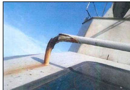
【Progress of corrosion, breakage of wiper】
