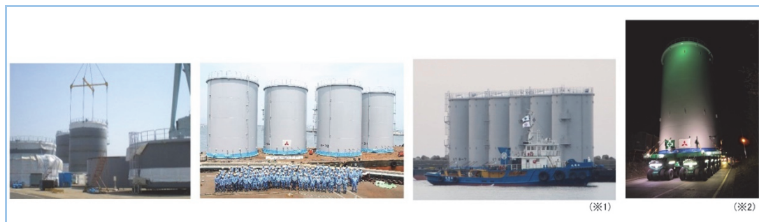
図6 汚染水タンク 工場製作～据付け
