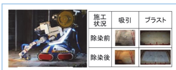
図8 除染状況(1号機 南西付近)
