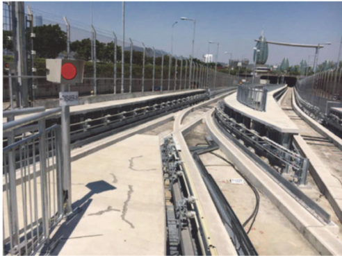
図7 沿線信号機器及び分岐
