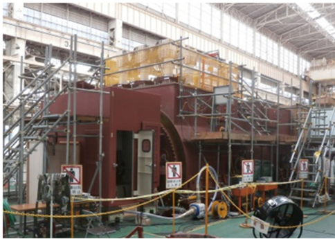
図5 工場回転試験時の組立状況
