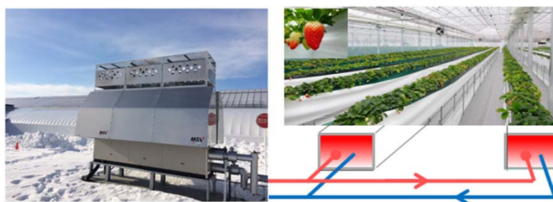
図8 北海道ハウス園芸への適用事例 (外気温度 -20^{\circ}\text{C} 以下の環境で運転)
