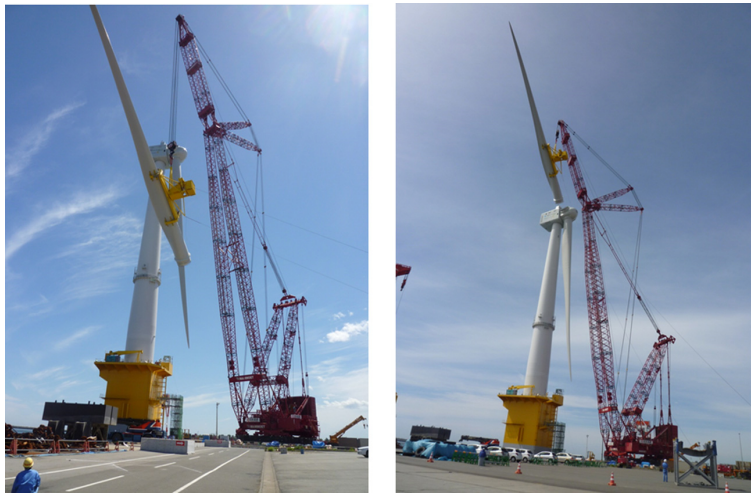
図5 小名浜港での風車搭載状況
