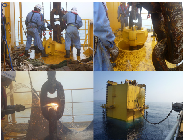
図8 福島沖での係留工事の状況
