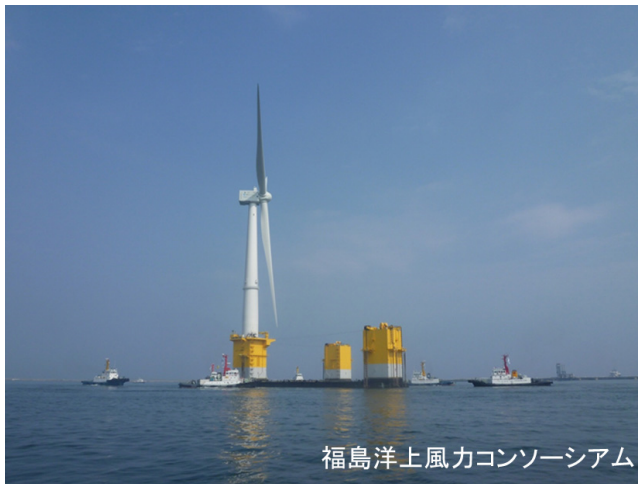
図7 風車搭載後に係留場所へ曳航される浮体
