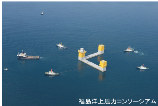
図2 長崎から小名浜への外洋曳航時のタグボート配置
