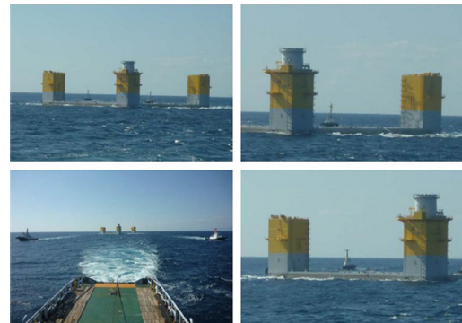
図3 長崎から小名浜への外洋曳航時の浮体状況
