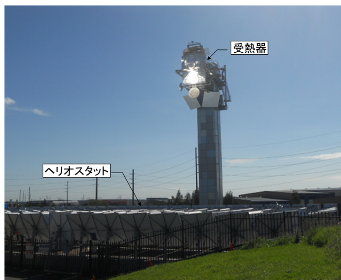
図5 CSIRO での受熱器単体試験風景
