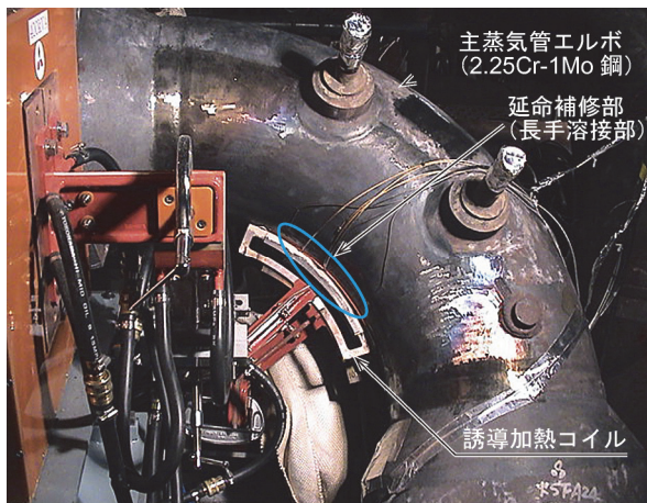
図6 再生熱処理の現場での施工性確認状況
