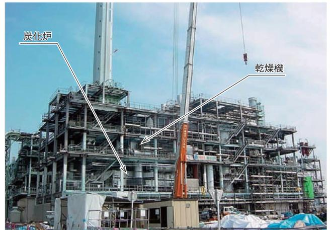
図5 下水汚泥炭化施設外観
