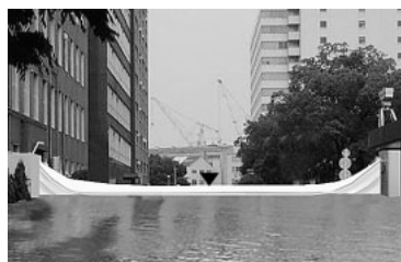
図8 膜式陸閘 迅速な開閉が可能であるとともに、地盤変形の影響を受けない。
