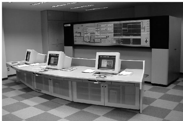
電力市場自由化に伴い、既設火力プラントにおいては、これまで以上の運用の多様化が望まれている。この実現のためには、高精度シミュレーションに基づくケーススタディが不可欠となってきており、本報ではその事例を紹介する。当社の高精度シミュレータは、実機各部の過渡的挙動をも忠実に模擬できる。この技術を使い高精度シミュレータで事前検証することにより、既設火力プラントの運用改善、機能確認、制御性検討に取り組んでおり、実際に効果が上がった実績が豊富にある。
