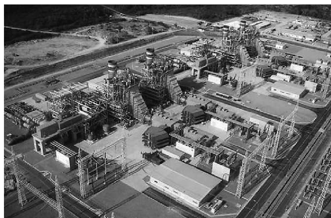
メキシコツクスパン 3・4 発電所 495 MW × 4 系列 コンバインドサイクルプラント 2003 年 5 月に 3，4 号機が運転開始。当社のメキシコでのコンバインドプラント総出力は 2 700 MW となった。
