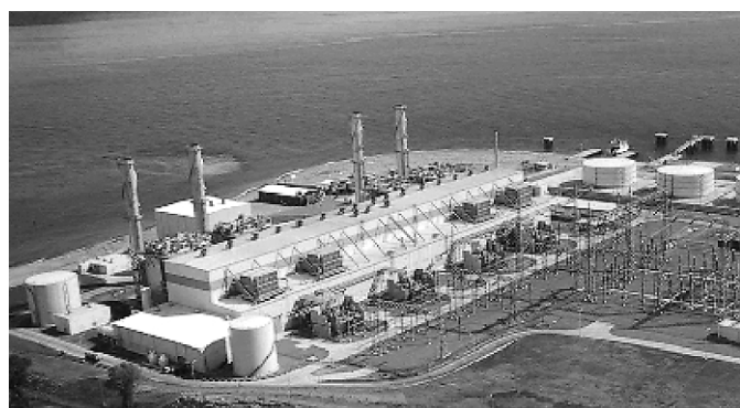
フィリピンイリジャン発電所 ガス／油焼き 600 MW × 2 系列，輸出初の G 形コンバインドサイクルプラント。
