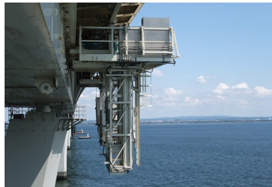
図6 アクアライン側面点検台車
