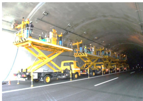
図2 2個口仕様の水噴霧測定車による消火設備点検状況
