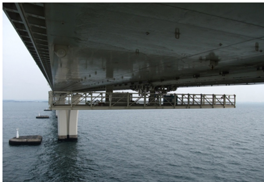
図5 アクアライン下面点検台車
