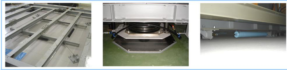
図2 免震床を構成する部品(左からコイルばね, 空気ばねとベアリング, オイルダンパ)
