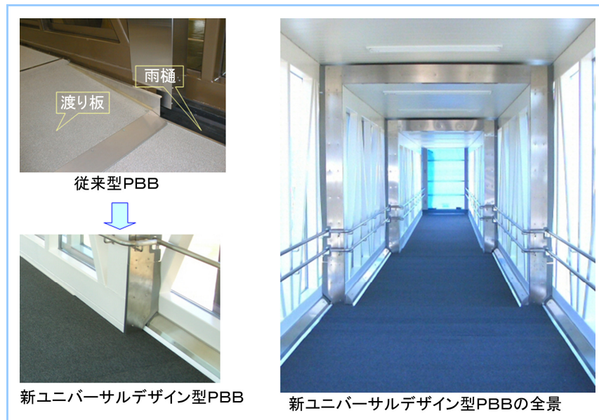
図2 トンネルと床板接続部
