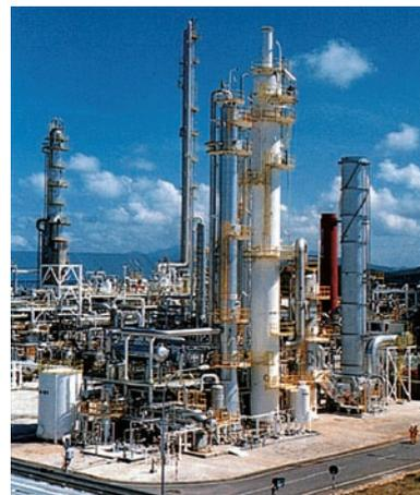
図2 マレーシアに納入したCO<sub>2</sub>回収装置
