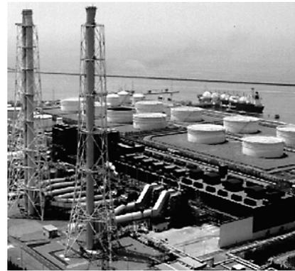
図10 東北電力(株)東新潟火力発電所 東北電力(株)東新潟火力発電所の全景を示す。第4-1号系列は事業用発電所では世界初のタービン入口ガス温度1450級ガスタービンを採用した。
