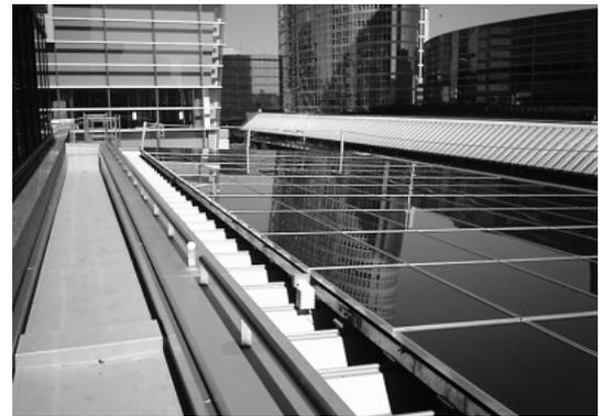
図16 高効率アモルファスシリコン太陽電池 アモルファスシリコン太陽電池の設置例を示す。家庭でも環境保全に寄与できる。
