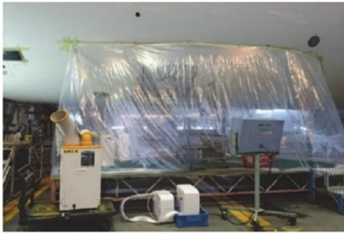
炭素繊維層に埃・水分が侵入することを防ぐため クリーンルーム内で複合材機体を修理する様子
