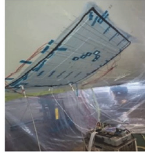
炭素繊維層を成形・ 温度検証して接着する様子
