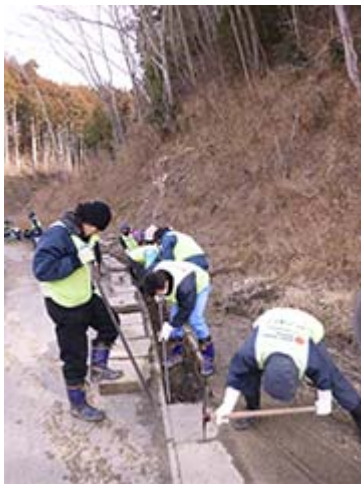
側溝泥出し作業
