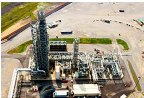
米国のCO 2 回収実証プラント
