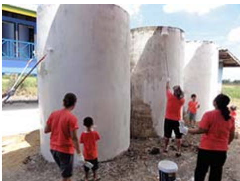
建物の補修の様子
