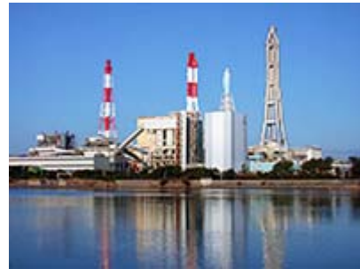
エネルギーの安定供給に大きく貢献。 石炭ガス化複合発電(IGCC)
