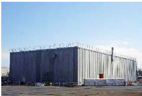
東京電力福島第一原子力発電所 G2エリアスラッジ貯蔵設備
