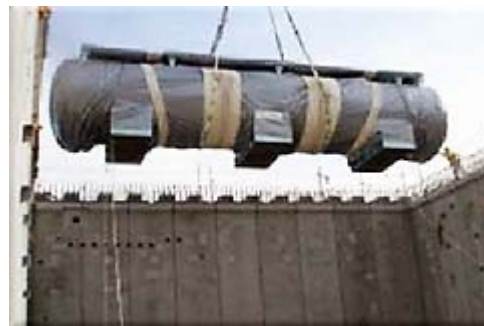
スラッジタンクの設置
