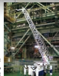
遠隔操作 ロボットによる バルブ開閉作業
