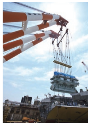
巨大なクレーンによるエンジンの設置
