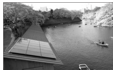
ポート場屋根に設置された太陽光発電設備
