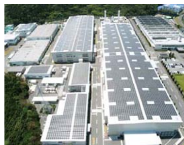
長崎造船所諫早工場「微結晶タンデム電池第2工場」に設置した太陽電池パネル
