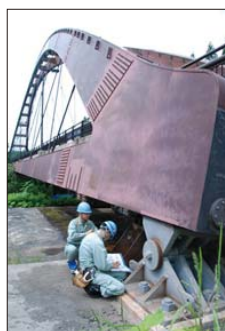
橋梁の安全点検
