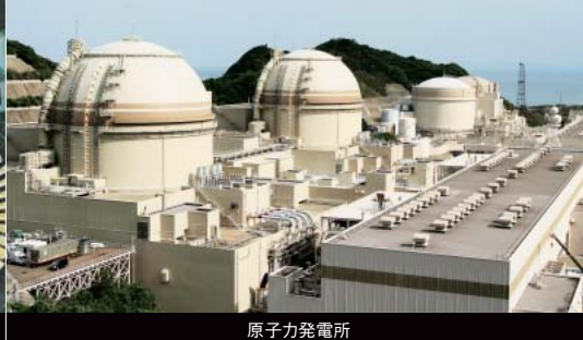
原子力発電所
