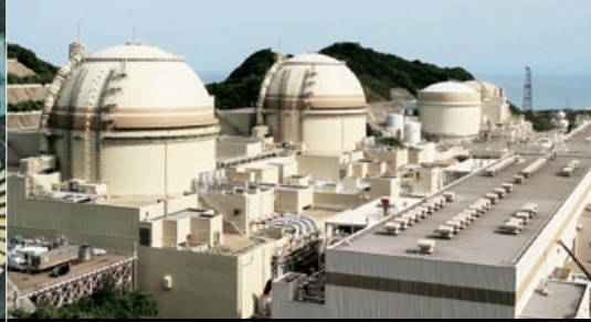
原子力発電所
