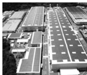
長崎造船所諫早工場「微結晶タンデム電池第2工場」に設置した太陽電池パネル
