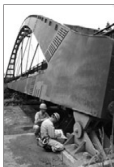
橋梁の安全点検
