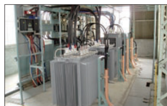
省エネルギー型の配電用変圧器
