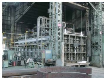
上) 金属加熱炉全景 右上) 燃料転換を実施した金属加熱炉 右下) パーナー部
