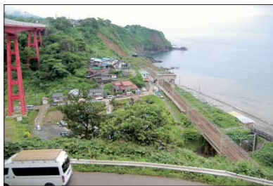
被災状況の激しい橋梁を優先的に調査
