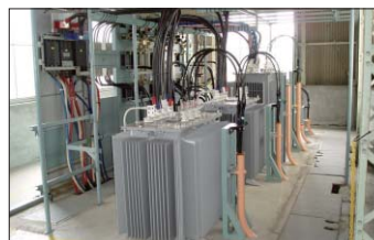
省エネルギー型の 配電用変圧器
