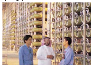
水資源が不足しているサウジアラビアで “海水から淡水をつくる”大型プラントを建設
