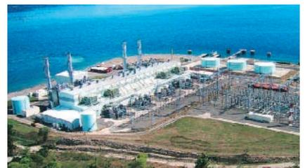
従来の火力プラントと比較して、約20%高いプラント効率を達成したガスタービンコンバインドサイクルプラント。高い排ガスエネルギーを有する高効率ガスタービンと排ガスボイラー、蒸気タービンなどで構成されている。
