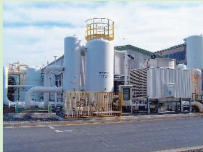
圧縮空気加熱器付き脱湿脱油装置
