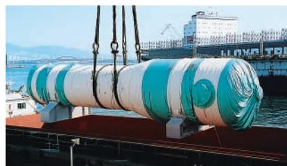
蒸気発生器(SG)は原子炉で発生させた熱によりタービン駆動用の蒸気を発生させるPWRの中核機器。当社は海外向け取替用SGをこれまでベルギー、米国、フランスへ計22基供給している。
