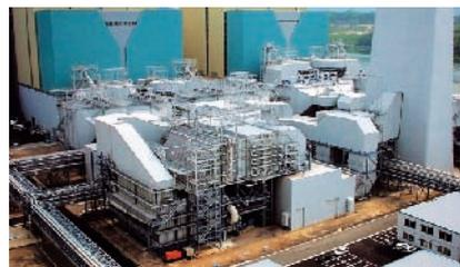
発電所などの排ガスに含まれる二酸化硫黄(SO<sub>2</sub>)を99.9%除去。独自の技術である液柱塔方式は、高い脱硫性能を達成するだけでなく、内部の構造をシンプルにしてメンテナンスを容易にし、お客さまの利便性に配慮している。
