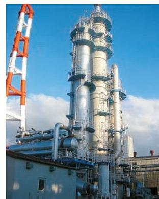
福岡のCO<sub>2</sub>回収プラントでは、1日283トンのCO<sub>2</sub>回収能力を持つ
