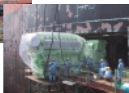
発電機入替作業
