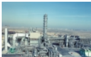
天然ガス改質プラント
