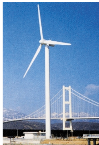
室蘭市1,000kWシステム
