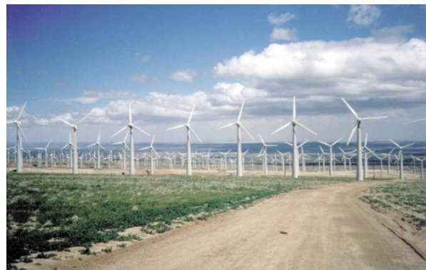
米国カリフォルニア州モハーベ 250kW×660ユニット／システム 世界最大面積 (1.4km×1.1km)
