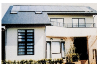
実証試験用住宅2kWシステム
