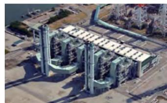
ガスタービン/蒸気タービン複合発電
