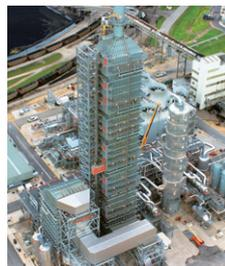
世界最大のCO<sub>2</sub>回収装置 (CO<sub>2</sub>回収量 4,776トン/日)
