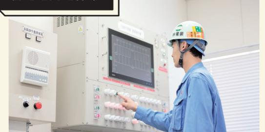
潜水艦に搭載している蓄電池への充電作業。各潜水艦への回路の確認、給電、電流制御を一手に担っています。
