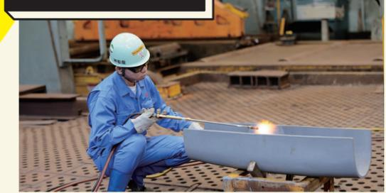
潜水艦の船体構造（主に曲面外板）を、ガスバーナー・プレス装置等を使用し滑らかな曲面に仕上げる匠の作業です。
