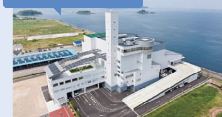
ごみ処理プラント 長崎県
