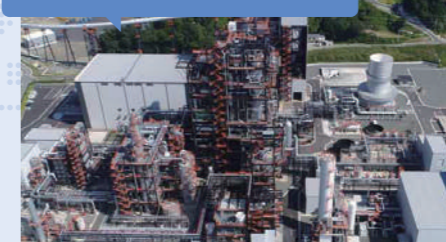
石炭ガス化複合発電プラント(IGCC) 福島県
