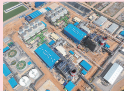
据付後試運転
