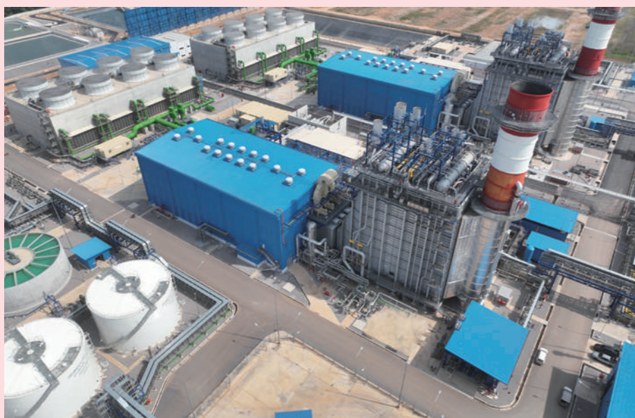
プラント完成
