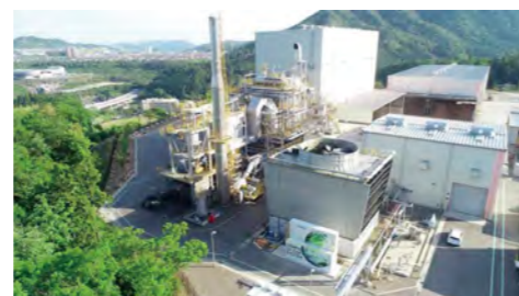
バイオマス発電所(CO 2 回収装置設置プラント)
