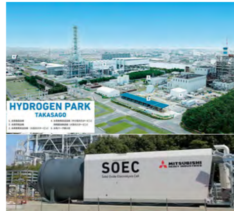
上: 水素製造から発電利用まで一貫実証可能な「高砂水素パーク」 下: SOEC_デモプラント(高砂水素パーク内)
