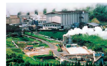
地熱発電プラント
