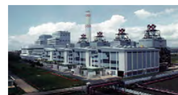
発電プラント
