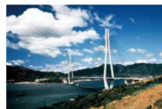
1999 日本最長 日本最長の斜張橋「多々羅大橋」完成
