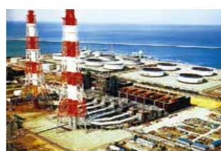
1985 世界最大級 世界最大級コンバインド発電プラント「東北電力、東新潟3号機第二系列545,000kW」完成
