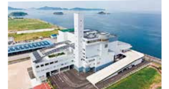
三菱重工環境・化学エンジニアリング(株) ごみ焼却発電施設
