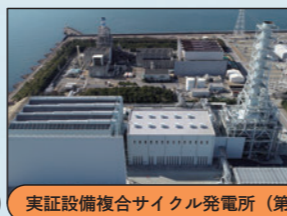
実証設備複合サイクル発電所 (第二T地点)
