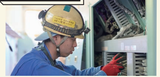
配線を終えた機器の結線をして送電する。
