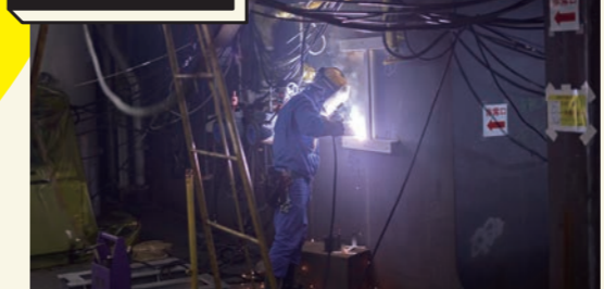
配線をするための電路や、機器を取り付けるための補機台の溶接。
