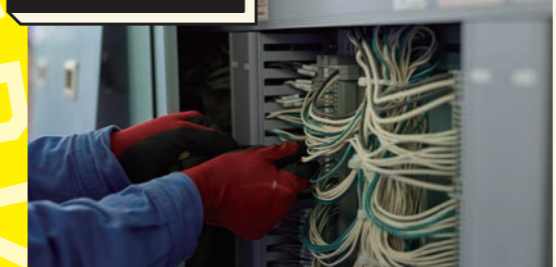
船内の機器から機器に配線をする。
