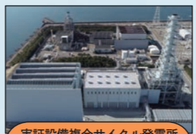
実証設備複合サイクル発電所 (第二T地点)
