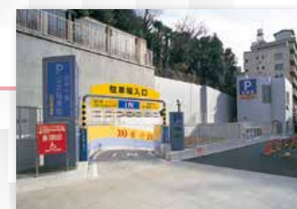
麻布十番公共地下駐車場(港区) [収容台数:325台]
