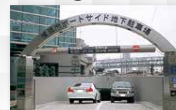
横浜市ポートサイド地下駐車場(横浜) [収容台数:200台]
