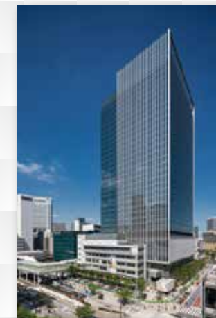
msb Tamachi(港区) [収容台数:110台]
