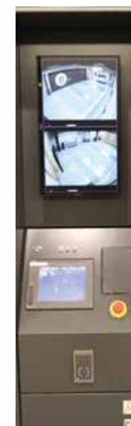
入庫カードリーダー盤 [新規証基準 場内安全] 確認モニタシステム
